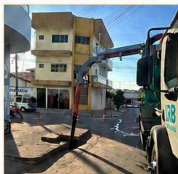
Atuação técnica em infraestrutura subterrânea no centro da cidade.
