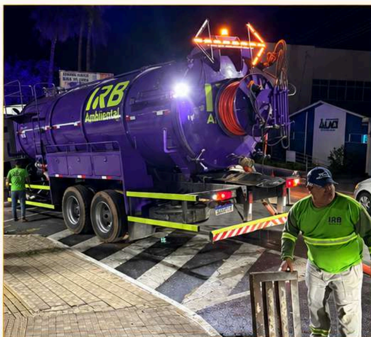
Equipe da IRB Ambiental durante serviço de limpeza e desobstrução de galerias em Ipameri.
