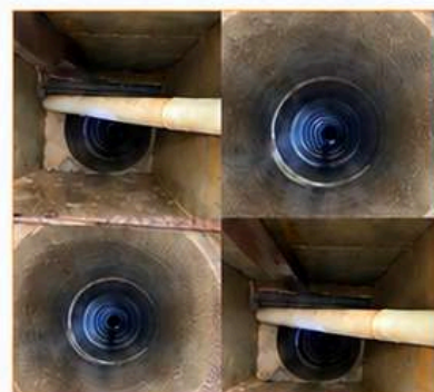
Galeria após limpeza e inspeção, com excelente resultado.
